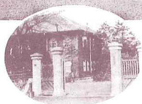
昭和四年改修以前 正門及本部建物一部の外観
