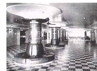
白木屋・7階ホール横の歩廊
