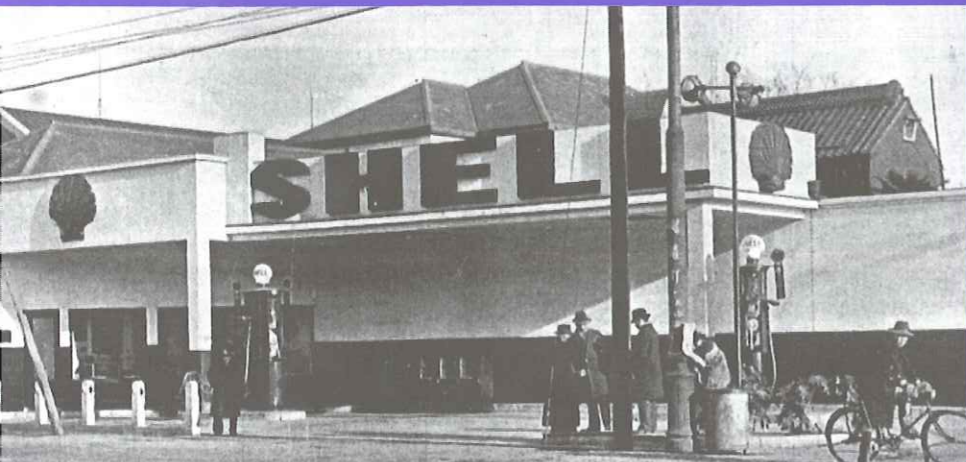
京浜国道 ライジングサン給油所
